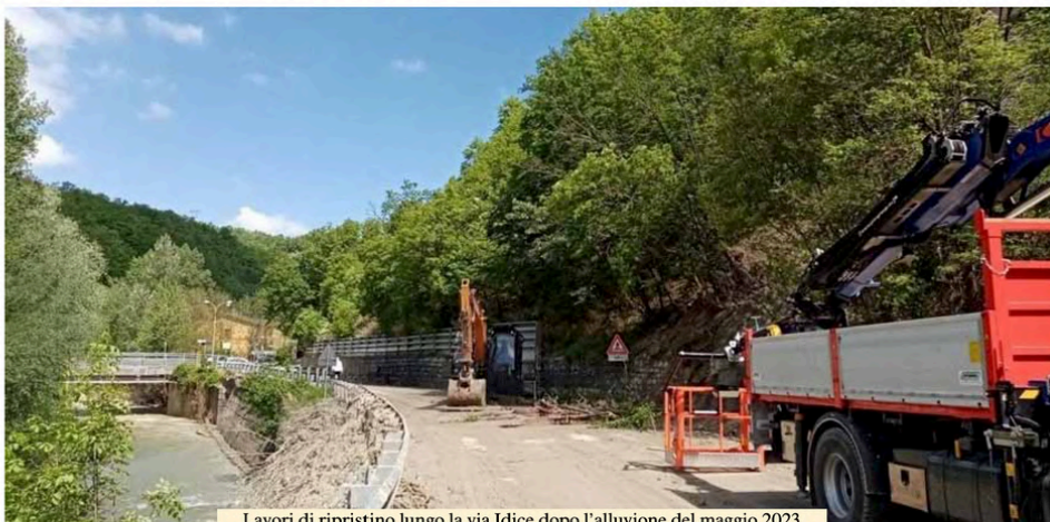
Lavori di ripristino lungo la via Idice dopo l'alluvione del maggio 2023
